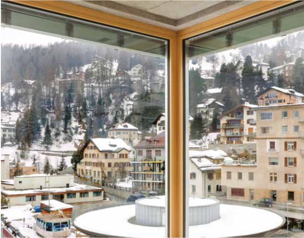
EgoKiefer Holz/Aluminium-Fenster WS1® Geschäftshaus, St.Moritz
