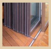
Die Elemente laufen unten auf hochwertigen, kugelgelagerten Rollenwagen und garantieren für Leichtgängigkeit und Langlebigkeit.
